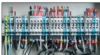
Bornier intégré dans l'armoire
